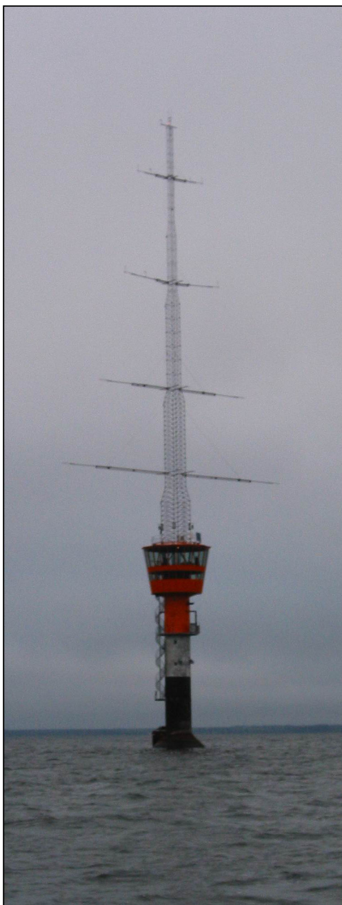
T.v. Fältstationen med mätmast. Bomlängderna är sex mastdiameterar Ö.h. Montage fältstation den 5 september 2003 M.h. Golvläggning övre plan N.h. Trapp från undre till övre plan
