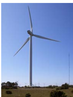
Bilden visar Vattenfalls Kenersysmaskin på näsudden. Denna är utrustad med kommunikationsgränssnitt som följer 61400-25.
